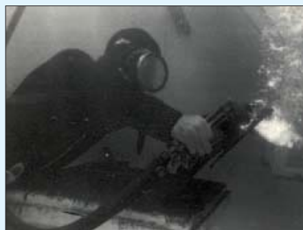
Trabalho de corte submarino com maçarico.
