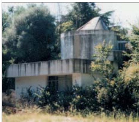
Aspecto do Observatório do Planetário antes do início das obras.
