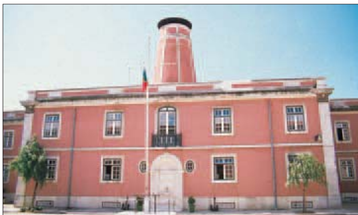
Fachada interior das I.N.A.
