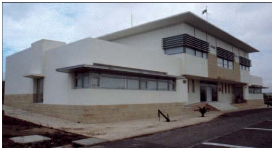
Edifício Administrativo do Comando Naval onde se encontra instalada a Célula Permanente.
