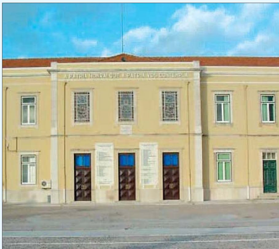
Edifício do Comando - fachada poente: ao centro são visíveis as lápides onde estão inscritas as acções em que tomou parte o Corpo de Marinheiros.
