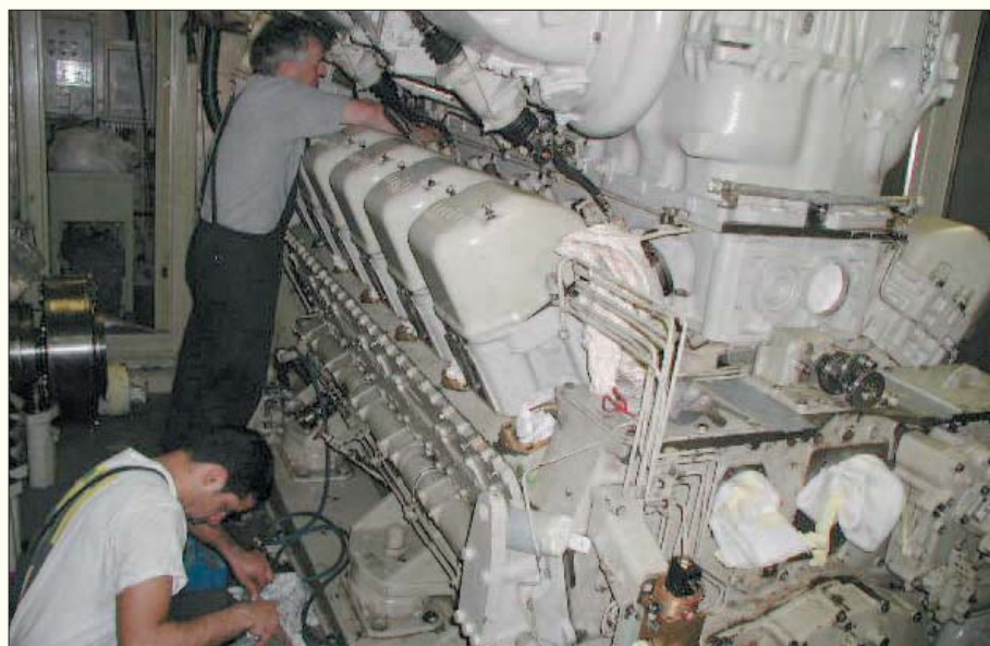
Trabalhos finais de montagem.
