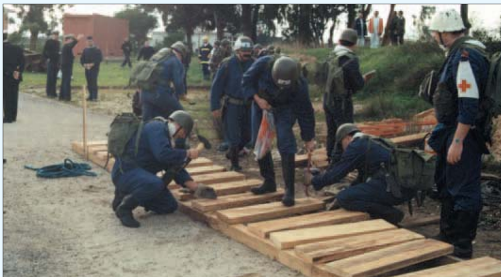
Construção de uma pequena ponte de acesso.
