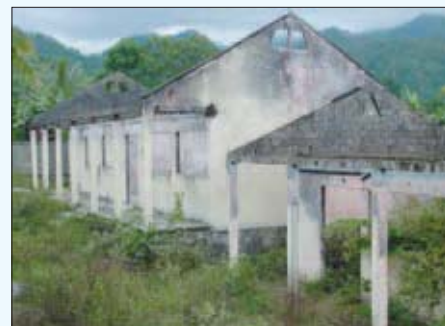
Escola de Same após as destruições de Setembro de 1999.
