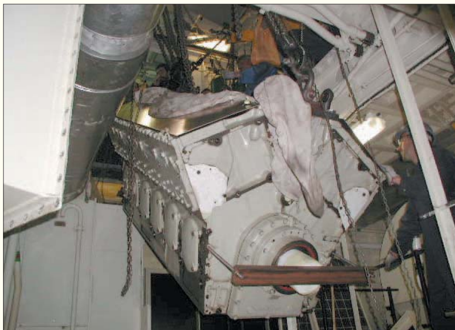
Fase crítica da movimentação do bloco. A extremidade de ré do veio de manivelas ainda não passou pela abertura.
