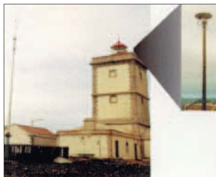
Fig. 1 - Estação DGPS experimental do Cabo Carvoeiro. Em primeiro plano vê-se a antena transmissora e junto à cúpula do farol a antena GPS (grande plano à direita).
