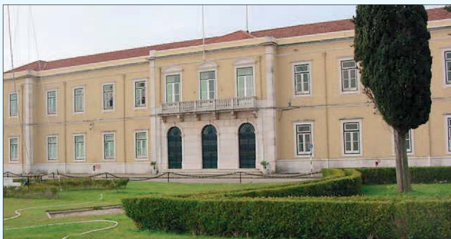
Edifício do Comando - fachada principal (Nascente).
