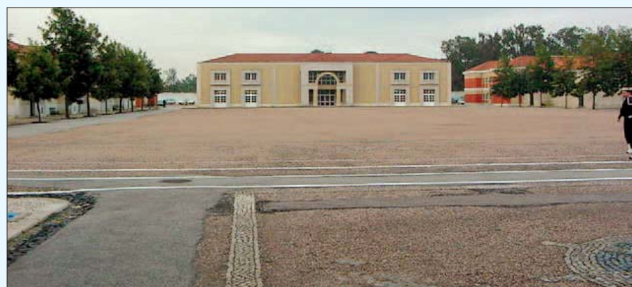
Parada do Grupo nº 2 de Escolas da Armada: apesar de terem sido construídos novos edifícios, a parada conserva a traça do projecto de 1914.
