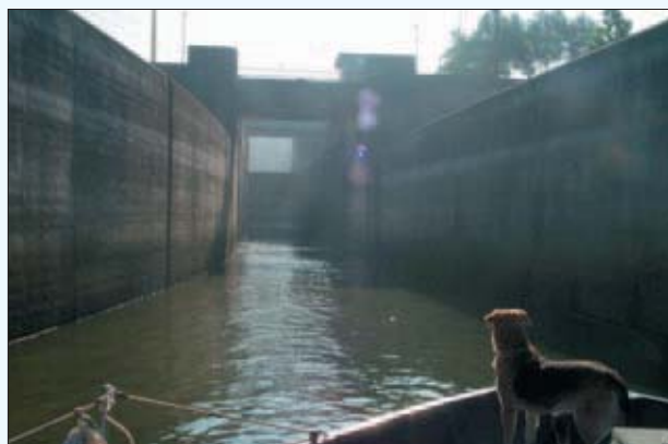
Eclusa da Barragem de Crestuma-Lever.
