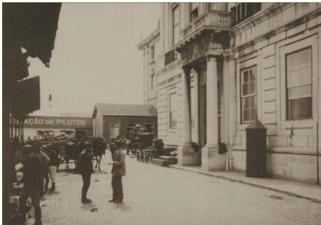
Recanto onde esteve situada no primeiro quartel do séc. XX a Capitania do Porto de Lisboa, a Estação dos Pilotos e a antiga Estação do Sul e Sueste.
