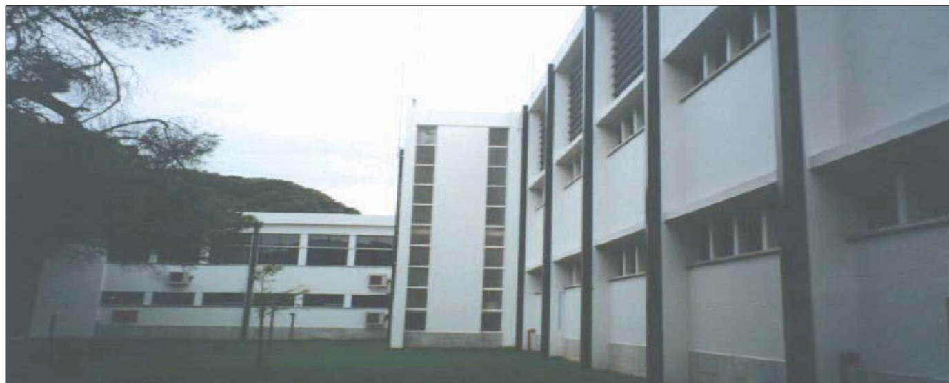
Alçado sul do edifício.
