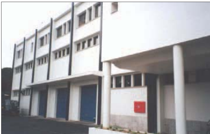
Alçado norte do edifício.
