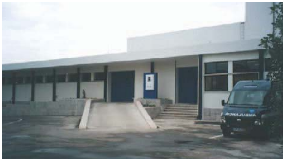
Novo arranjo da fachada principal.
