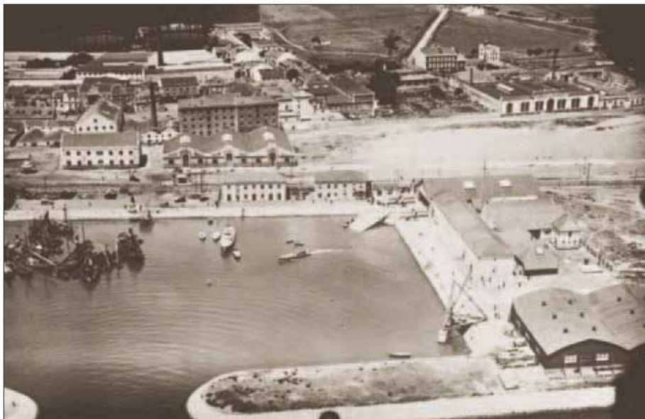
A Doca do Bom Sucesso tendo à direita o hangar dos hidroaviões e o edifício do Comando.
