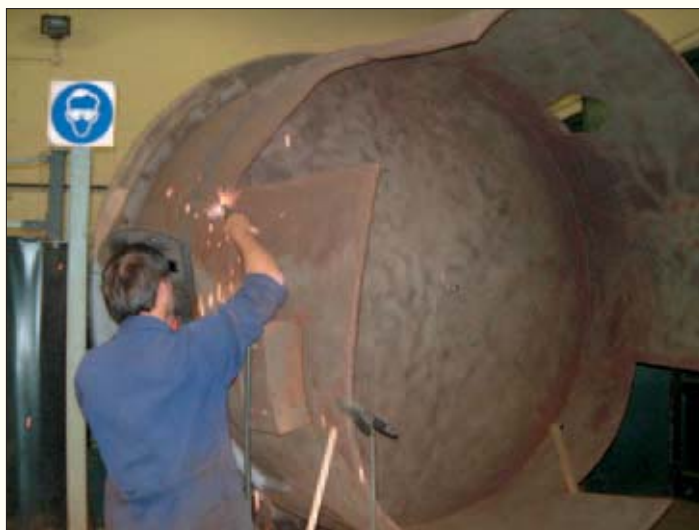
Uma bóia em manutenção.
