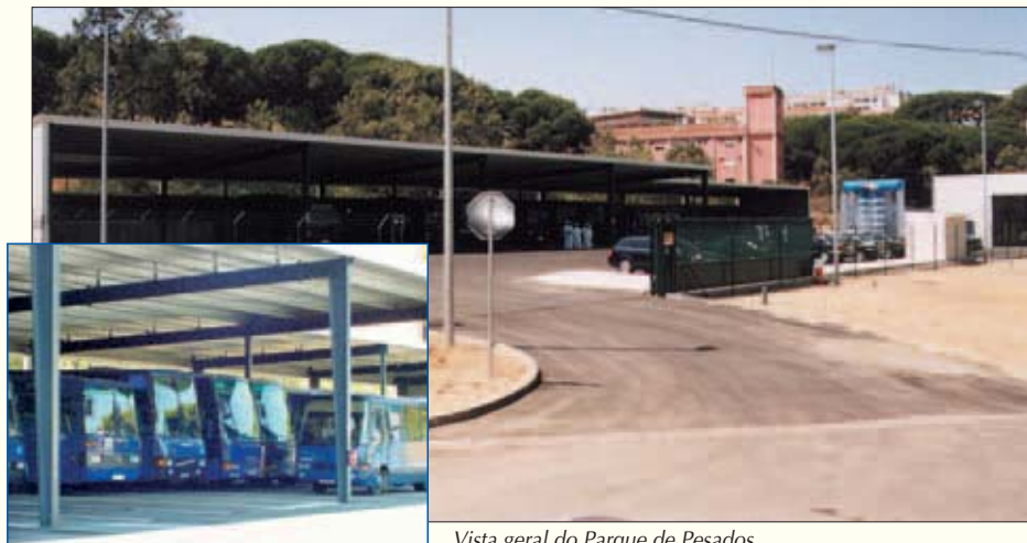
Vista geral do Parque de Pesados.
