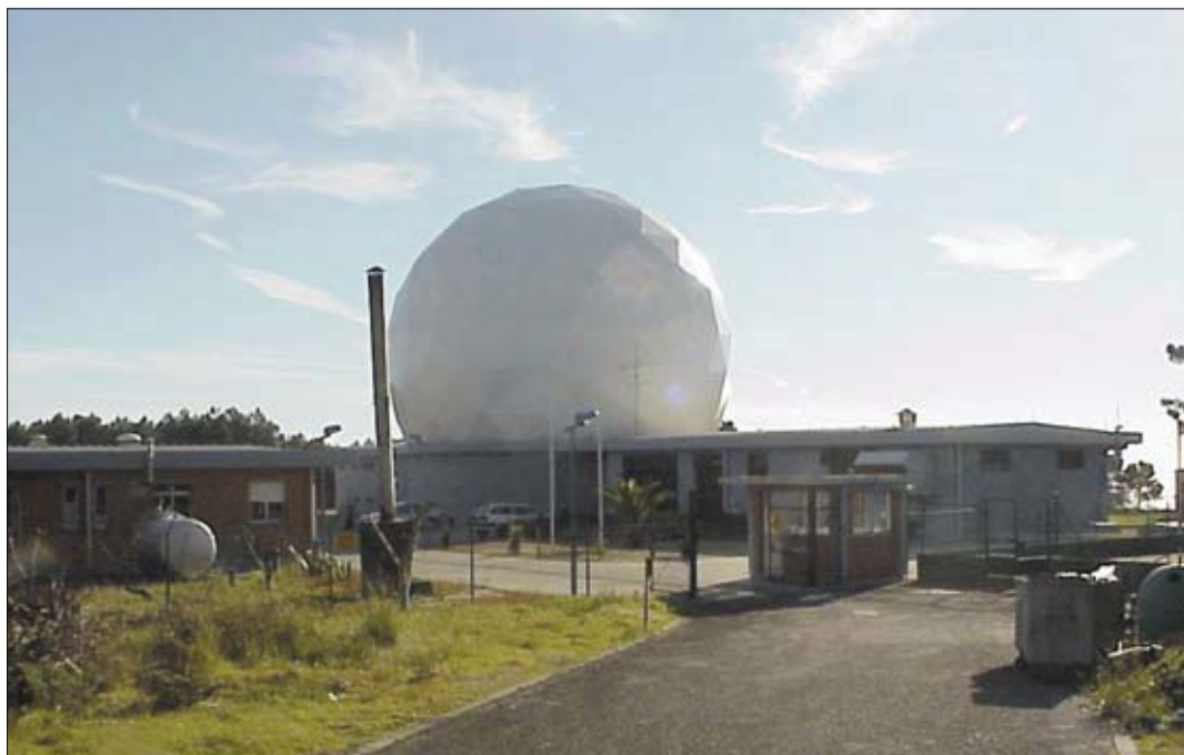
Vista geral da Estação Ibéria.
