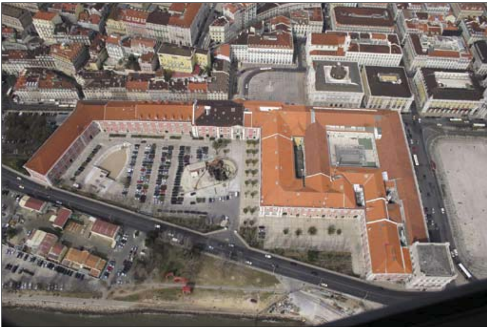
Os novos telhados da “Nau de Pedra”.
