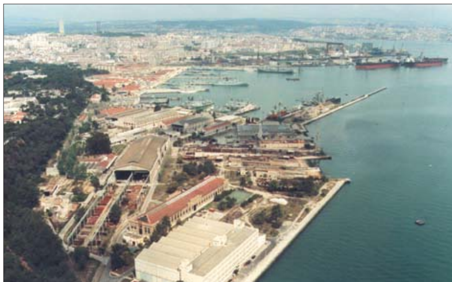
Vista aérea do Arsenal do Alfeite.
