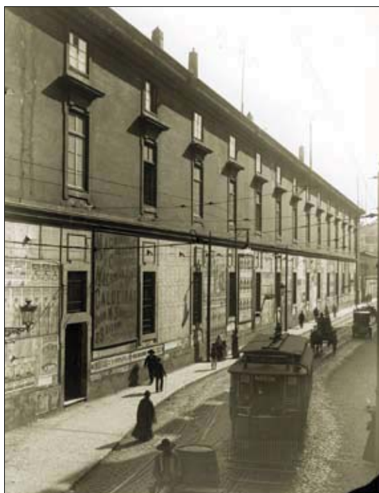
Entrada da Escola Naval na Rua do Arsenal.
