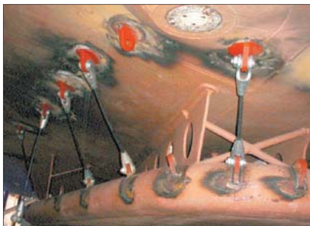
Fig. 6 – Instalação de cabos de aço em doca.
