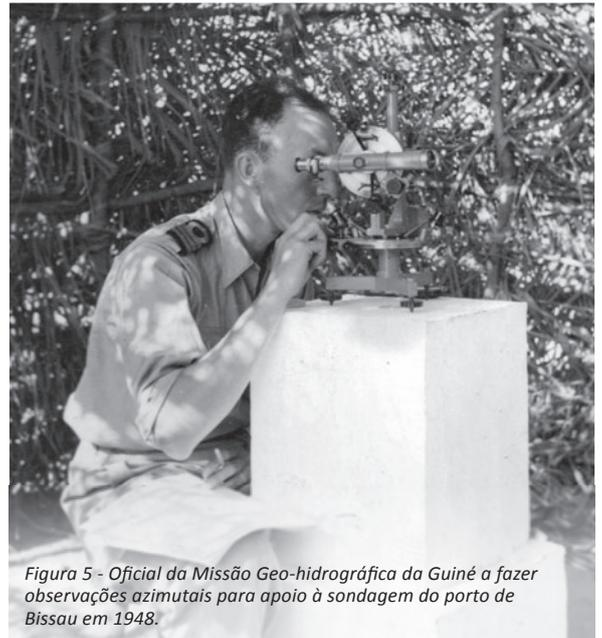
*Figura 5 - Oficial da Missão Geo-hidrográfica da Guiné a fazer observações azimutais para apoio à sondagem do porto de Bissau em 1948.*
