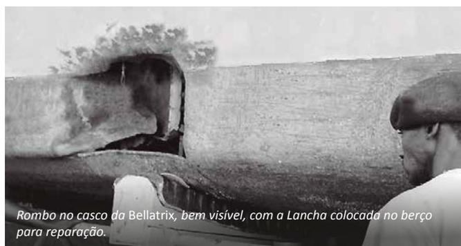
Rombo no casco da Bellatrix, bem visível, com a Lancha colocada no berço para reparação.
