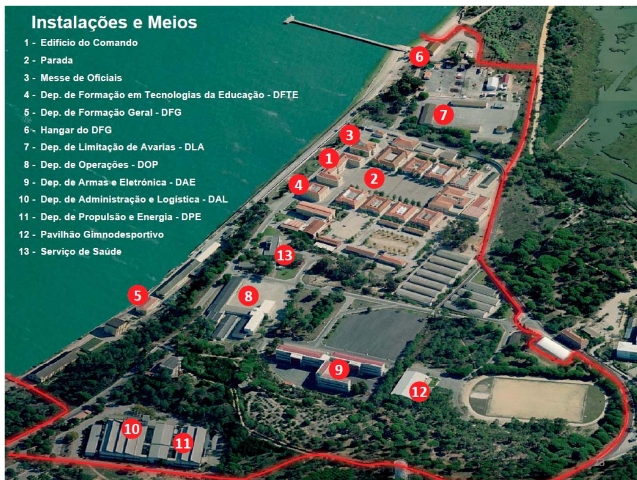
Figura 2 – Imagem aérea da ETNA identificando principais instalações e meios.
